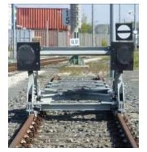
Schutzsignal **Sh 0** (Halt! Fahrverbot) ist als Formsignal am Prellbock im Gleis 81,91 und 101 angebracht.
